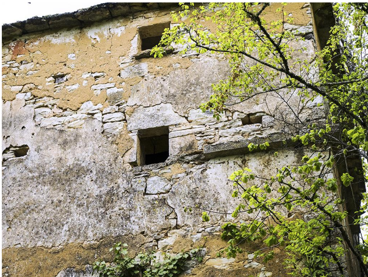
Fig. 32 - Le pigeonnier : lucarnes et randière en haut de la façade Est.
