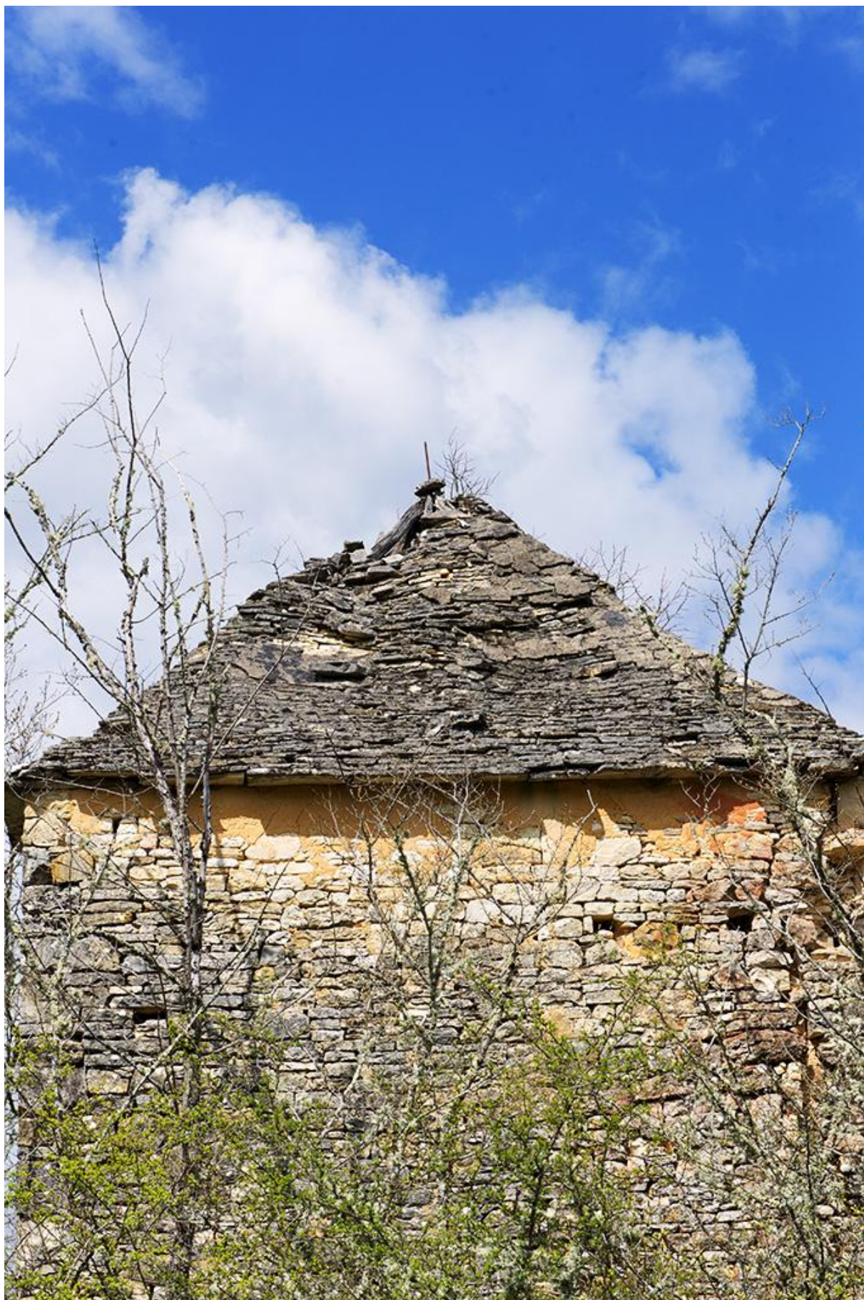
Fig. 43 - Le pigeonnier : détail de la toiture de lauses côté Sud.
