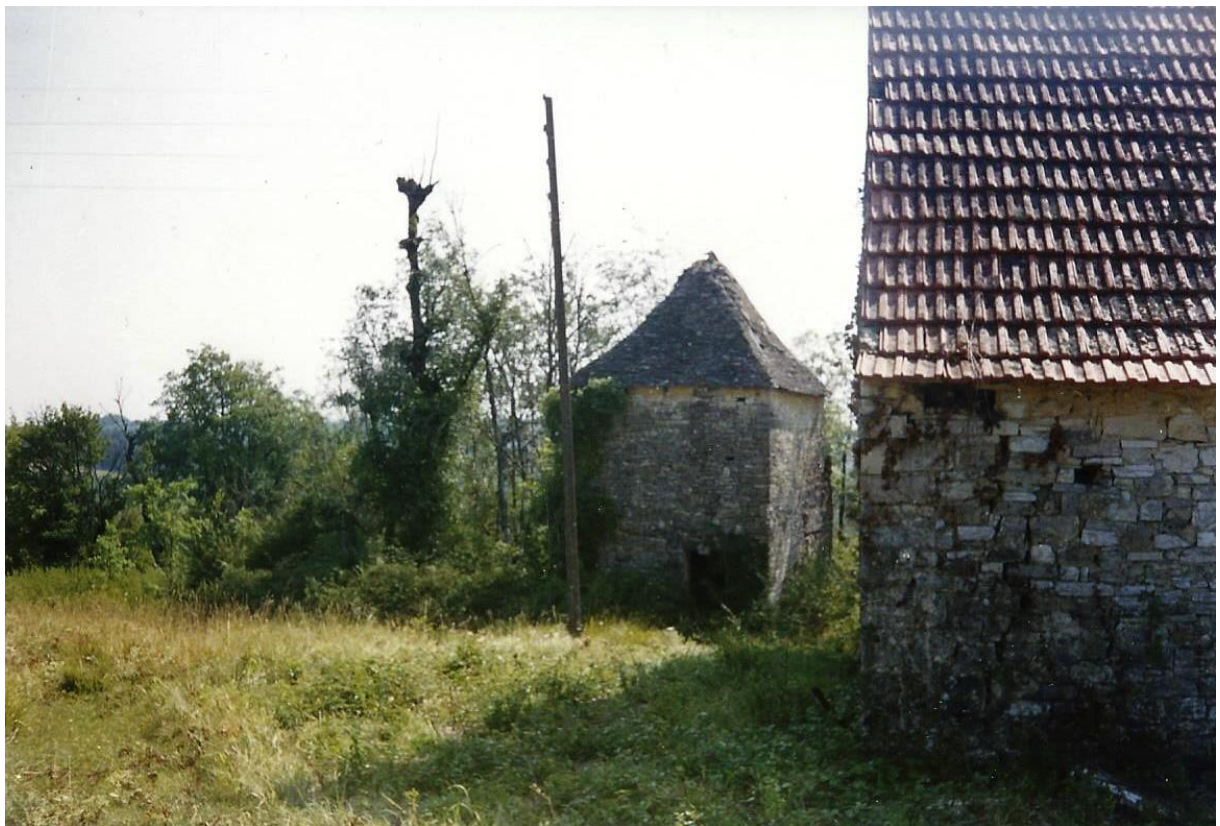
Fig. 73 - Au premier plan l'angle du pignon de la grange No 2, à l'arrière-plan le pigeonnier.
