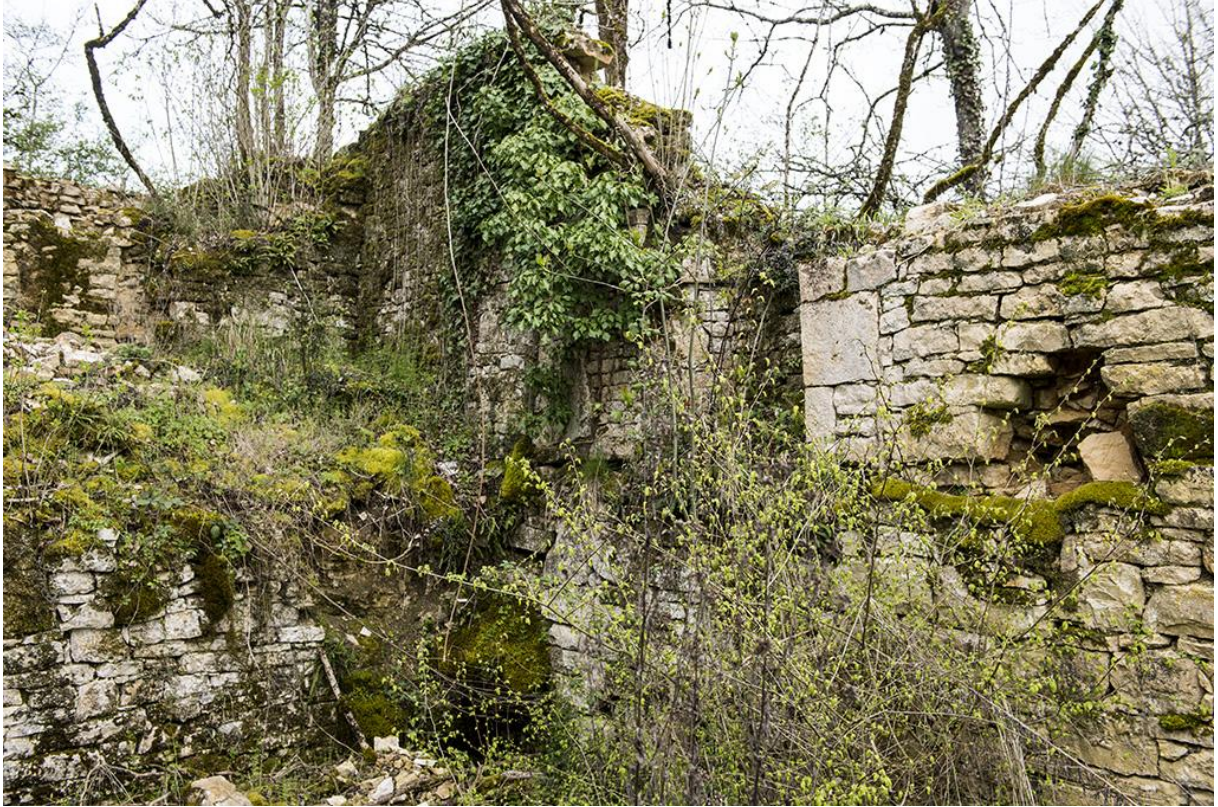
Fig. 38 - Ruines 1 et 2 de la maison des Gascou.
