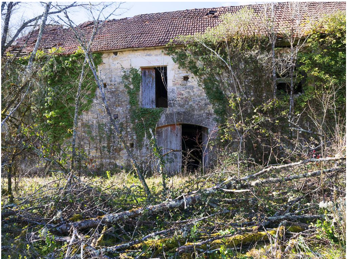
Fig. 26 - Grange N° 2 : la porte centrale et la fenêtre qui la surmonte.
