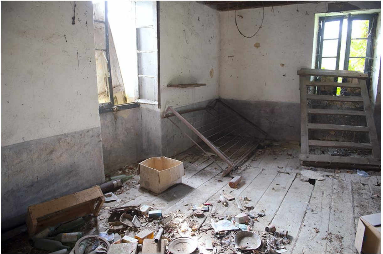
Fig. 15 - La maison : la chambre et la deuxième fenêtre de la façade Est.
