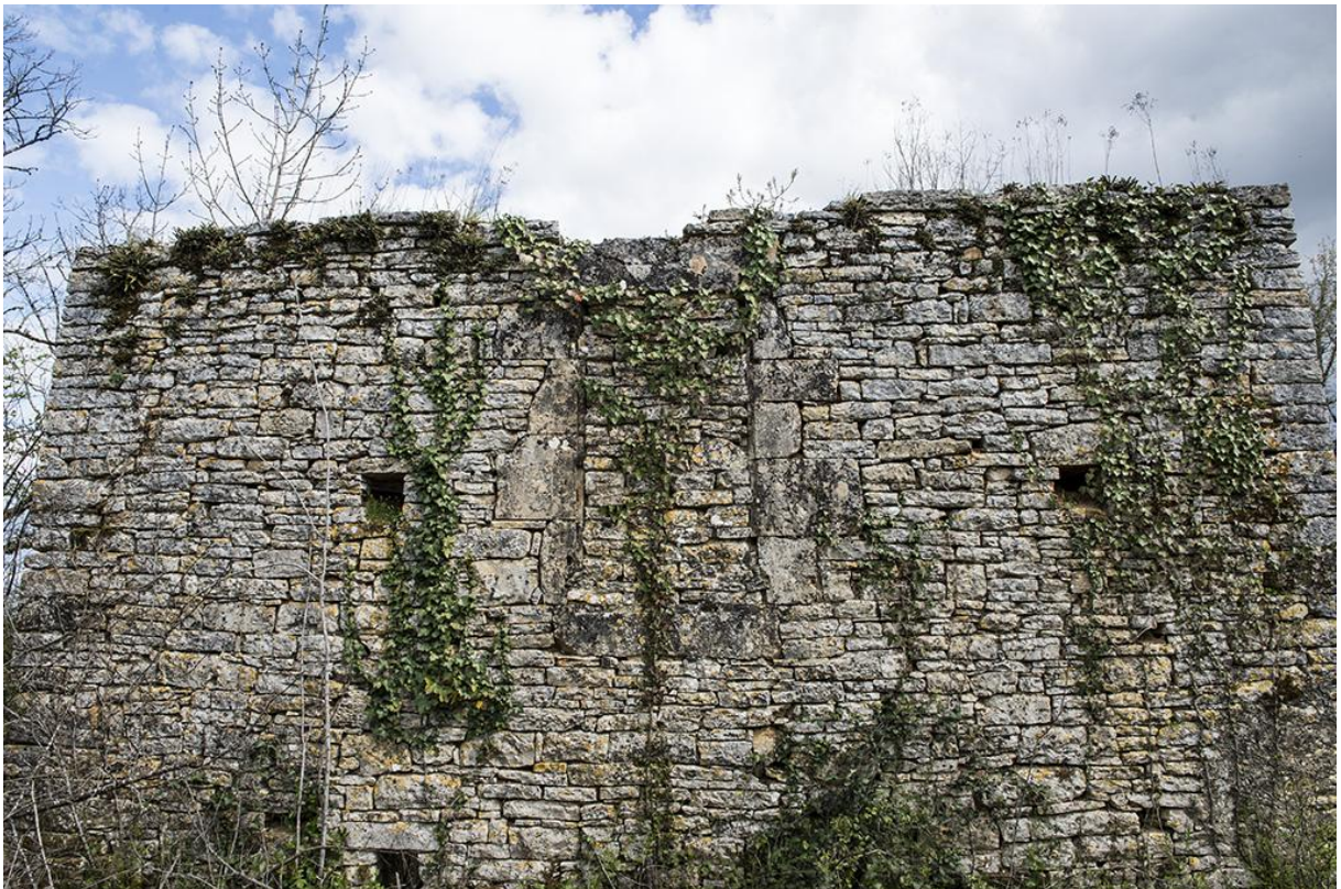
Fig. 39 - Ruine de la maison des Huzol (appartenant aujourd'hui à François Godard) : mur du pignon Ouest avec sa fenêtre condamnée.
