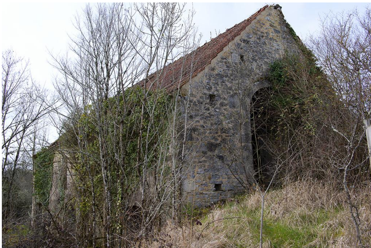
Fig. 27 - Grange N° 2 : pignon Nord.
