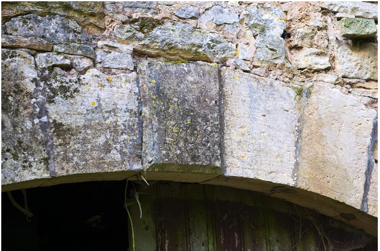
Fig. 19 - Grange N° 1 : clé de l'arc surbaissé de la première entrée du gouttereau Nord, millésime 1908.
