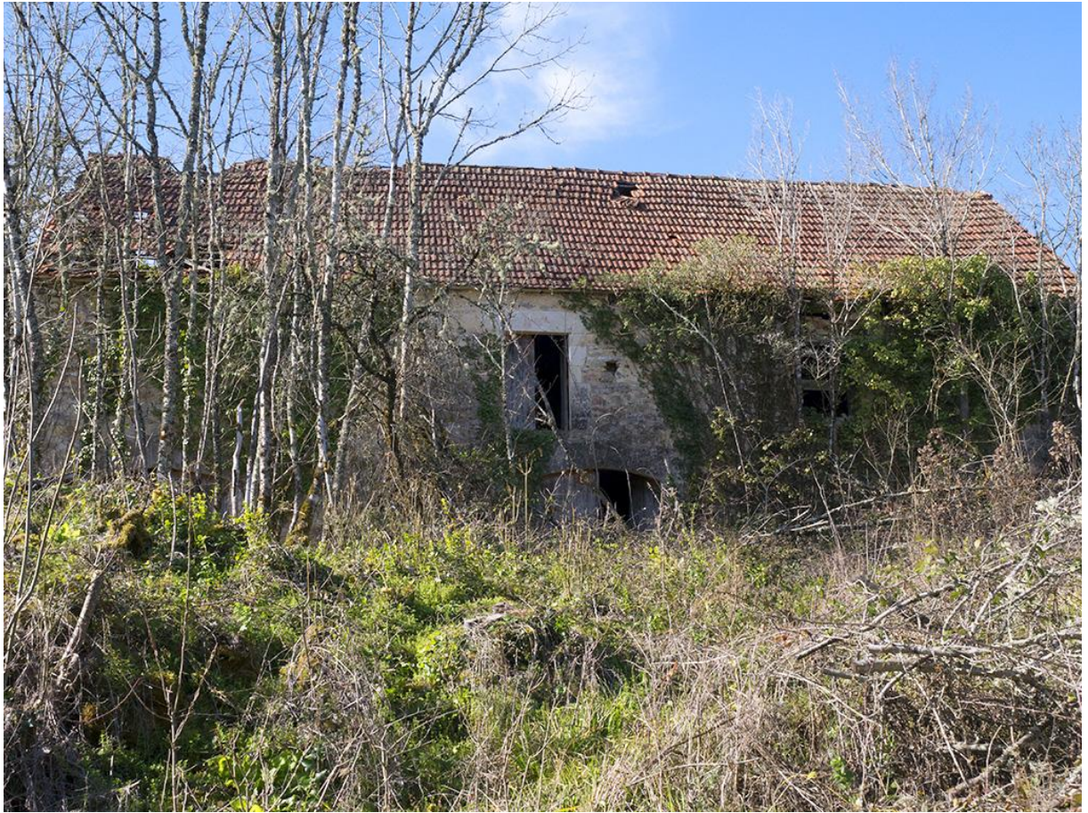
Fig. 25 - Grange N° 2 : façade Est.
