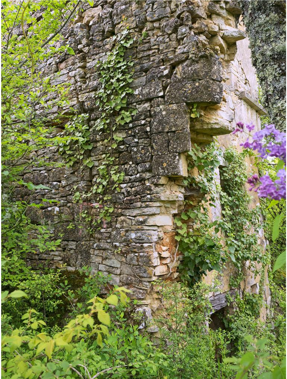
Fig. 35 - Le pigeonnier : la base du mur Sud, avec une ouverture condamnée, sous le lierre, et l'amorce d'une construction attenante.
