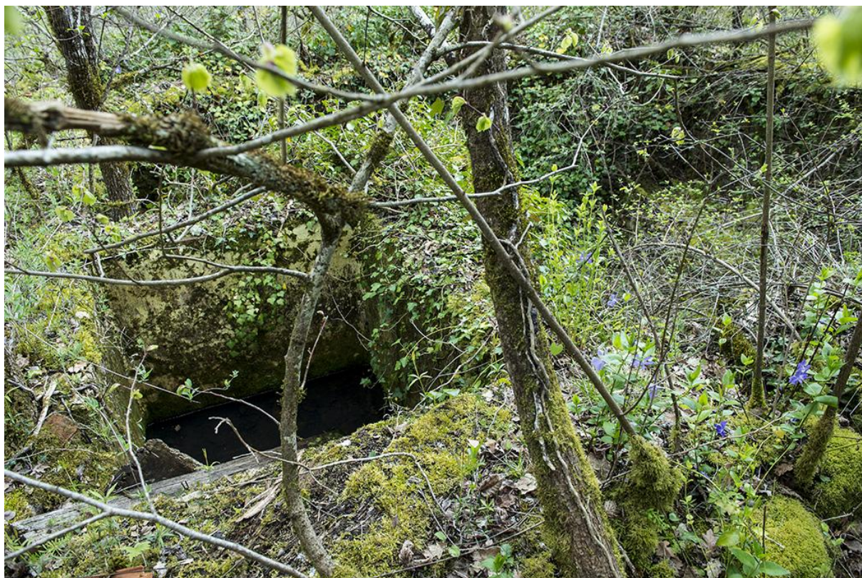
Fig. 42 - Citerne de la ruine N°7, voir figure 8.
