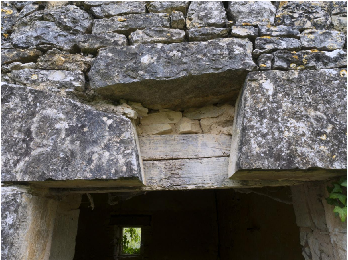
Figure Fig. 51 - Le pigeonnier : emplacement de la clé de la plate-bande de l'entrée Ouest.
