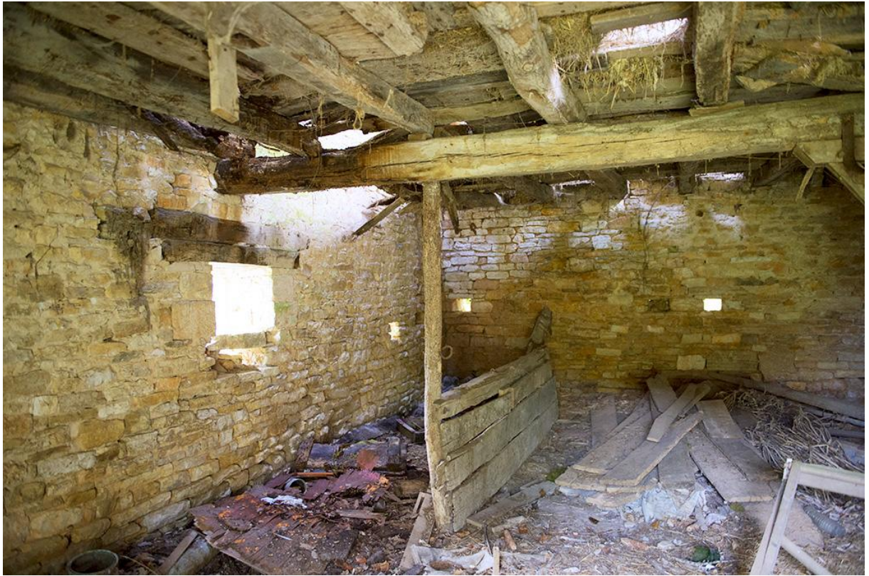
Fig. 22 - Grange N° 1 : le pignon Est et son « fenestrou » à partir de la seconde entrée de la façade.
