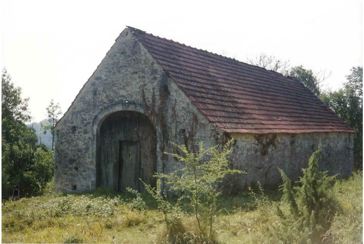
Fig. 72 - Pignon de la grange No 2 avec son entrée coiffée d'un arc en anse de panier.
