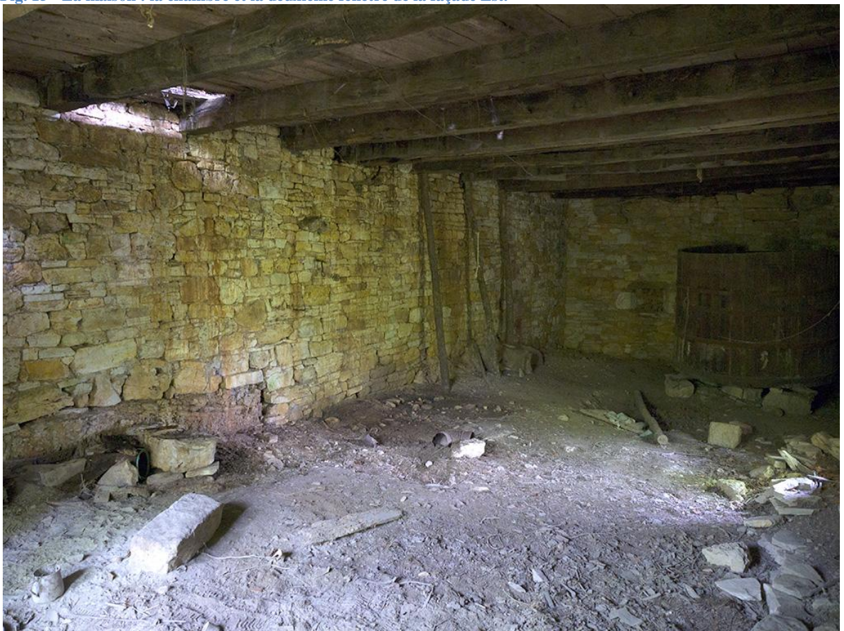
Fig. 16 - La maison : la cave, avec la cuve au fond ; à gauche, le rocher servant d'assise à la maçonnerie.
