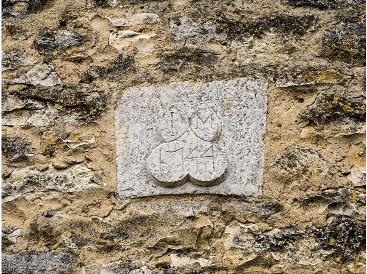
Fig. 52 - Le pigeonnier : ancienne clé de la plate-bande de l'entrée du pigeonnier.
