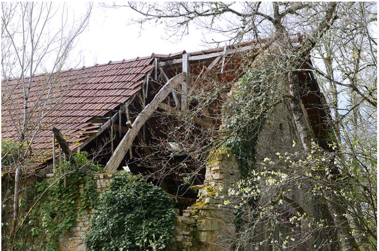
Fig. 23 - Grange N° 1 : la couverture détoiturée côté Ouest.
