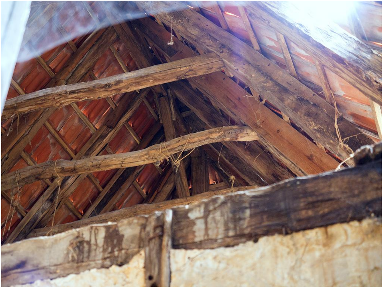
Fig. 11 - La maison : les combles en contre-plongée.
