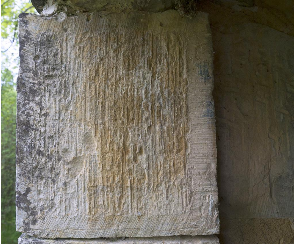
Fig. 34 - Le pigeonnier : la taille d'un angle de l'entrée Ouest.
