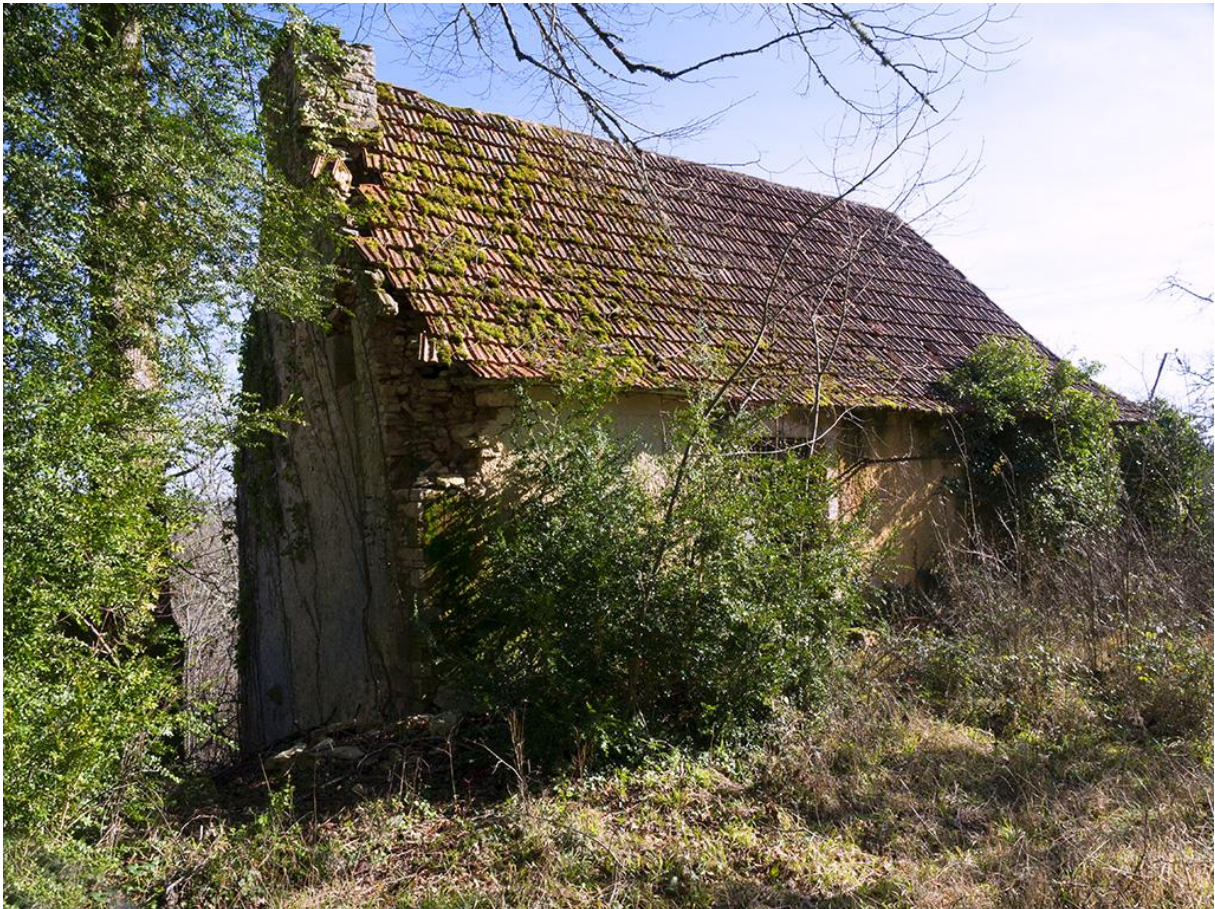
Fig. 9 - La maison : pignon Nord et la façade Ouest.
