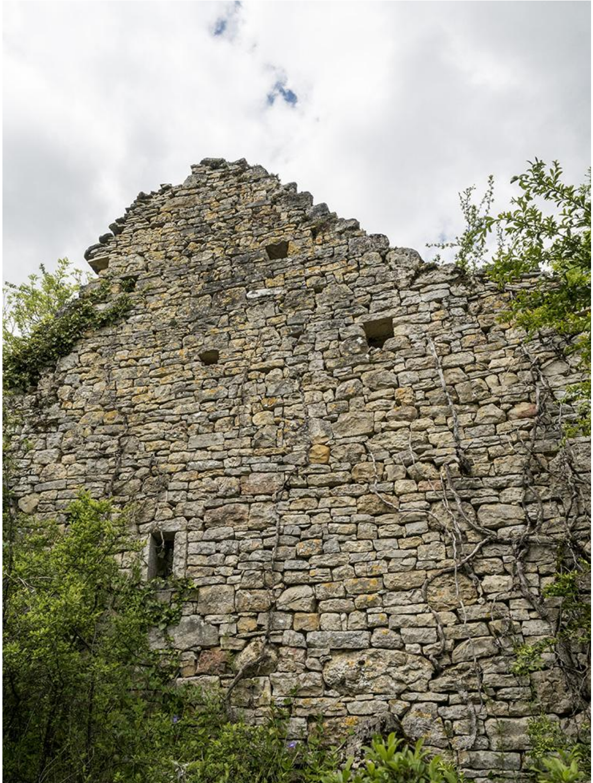
Fig. 43 - Mur pignon de la ruine N°10, voir figure 8.
