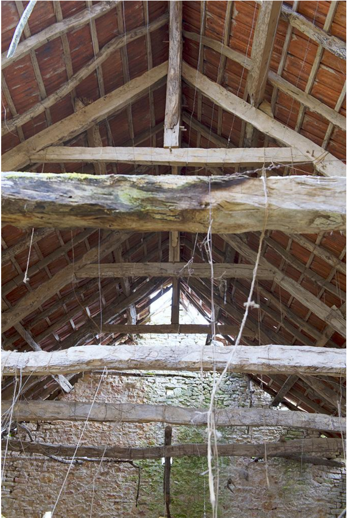
Fig. 30 - Grange N° 1 : la charpente de l'étage.
