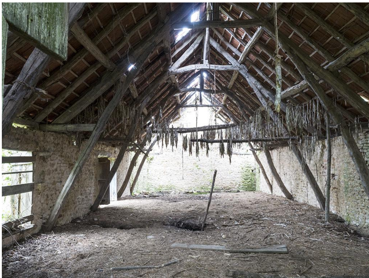
Fig. 39 - Grange N° 2 : l'étage et la charpente.
