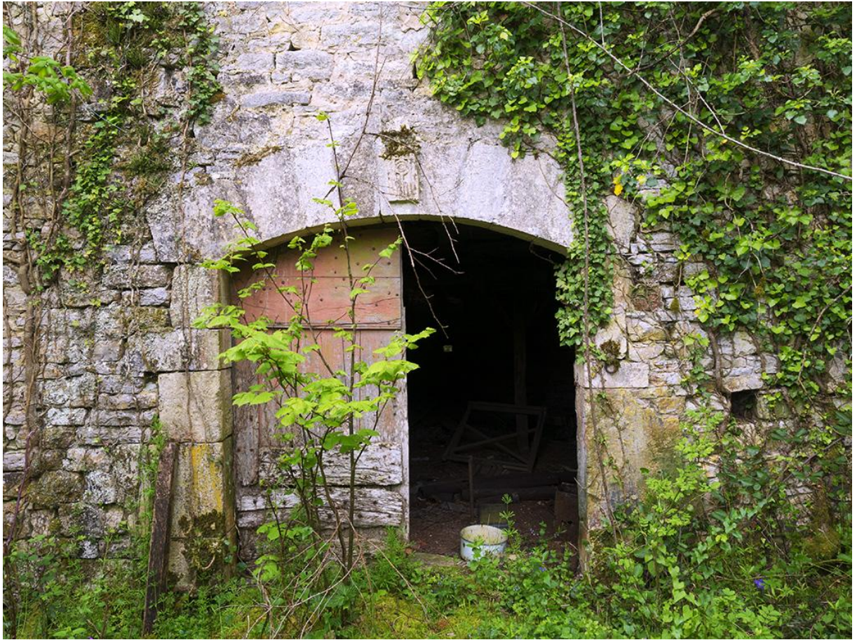
Fig. 18 - Grange N° 1 : la seconde entrée, en arc surbaissé, du gouttereau Nord.
