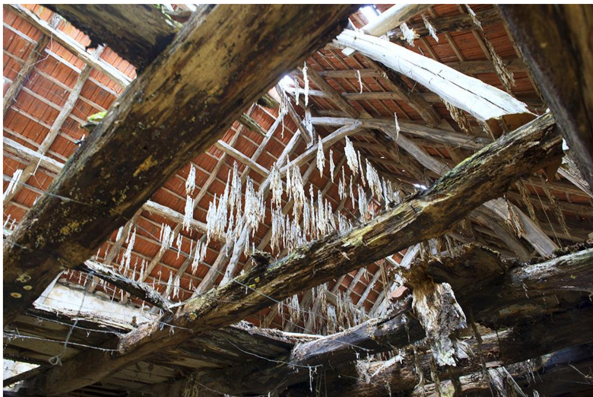
Fig. 28 - Grange N° 2 : restes de tabac séché pendu sous la toiture.
