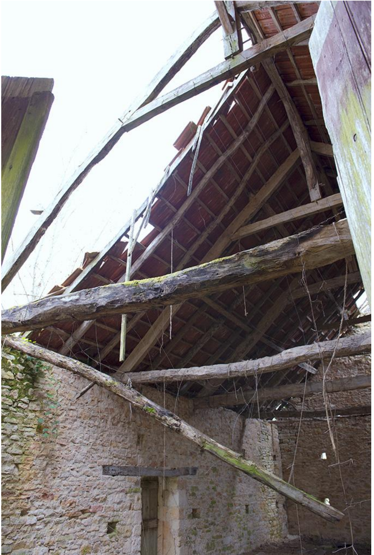
Fig. 29 - Grange N° 1 : intérieur de l'étage, avec la fenêtre de la façade Nord.
