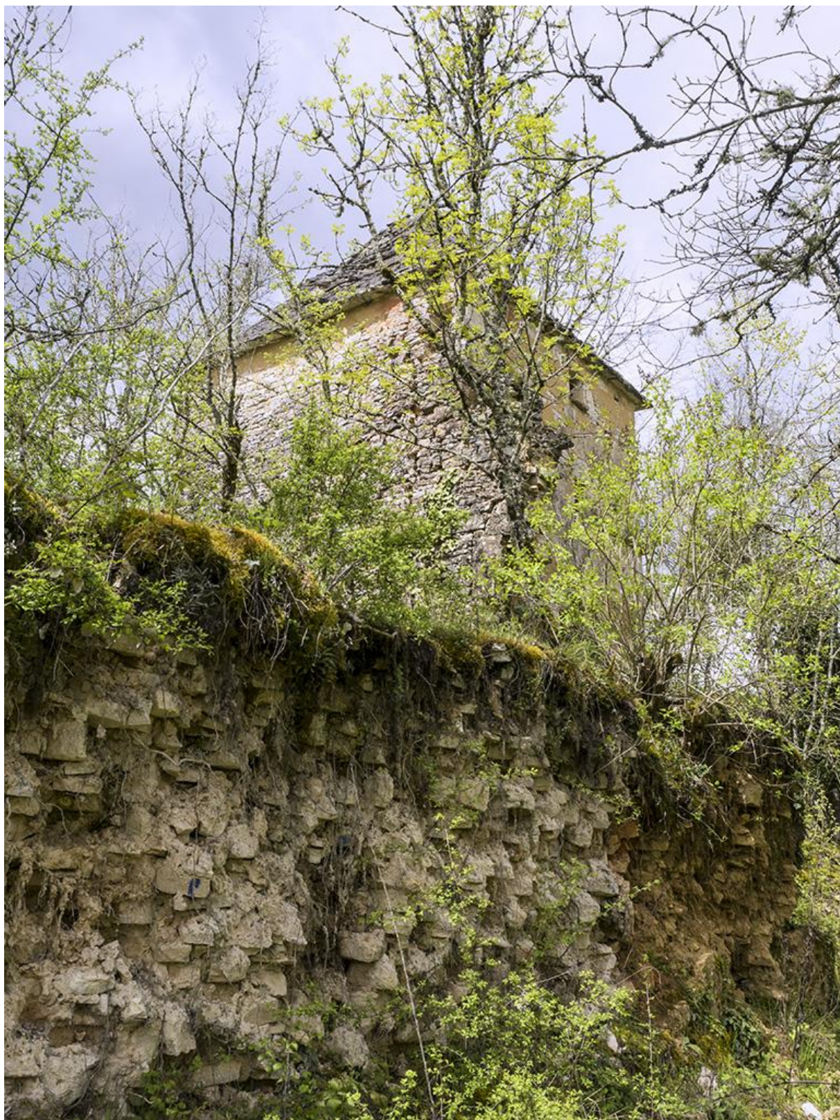
Fig. 33 - Le pigeonier : vue vers le mur Sud ; au premier plan, le long du passage d'accès, le mur a vu ses pierres de parement arrachées.
