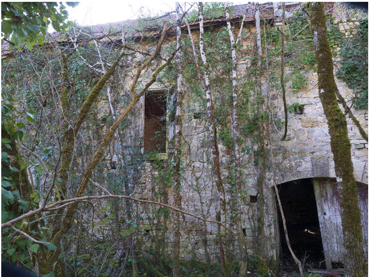
Fig. 17 - Grange N°1 : partie de la façade Nord.
