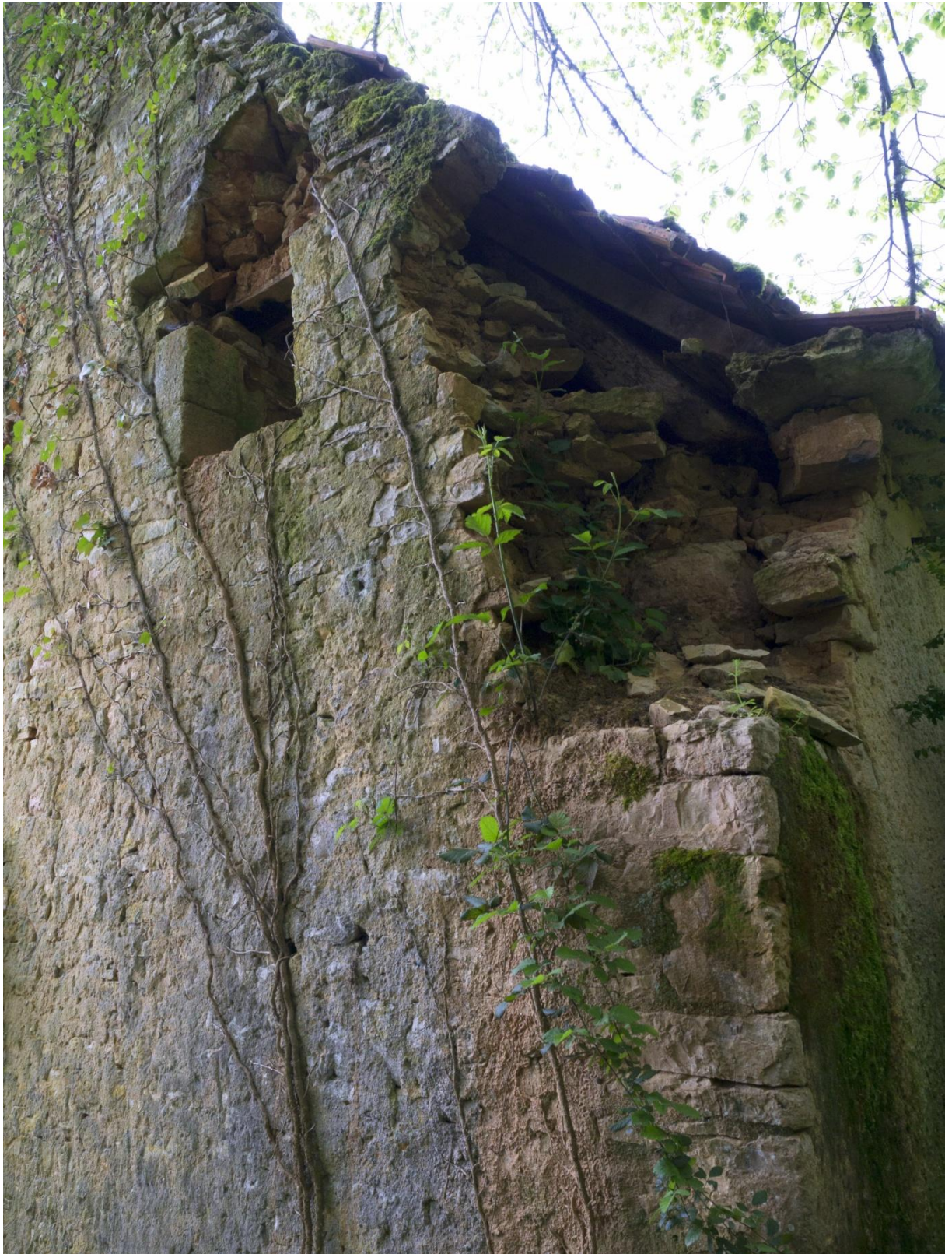
Fig. 13 - La maison : pignon Nord et détail des arrachements (chaînage d'angle et linteau de la fenêtre des combles).
