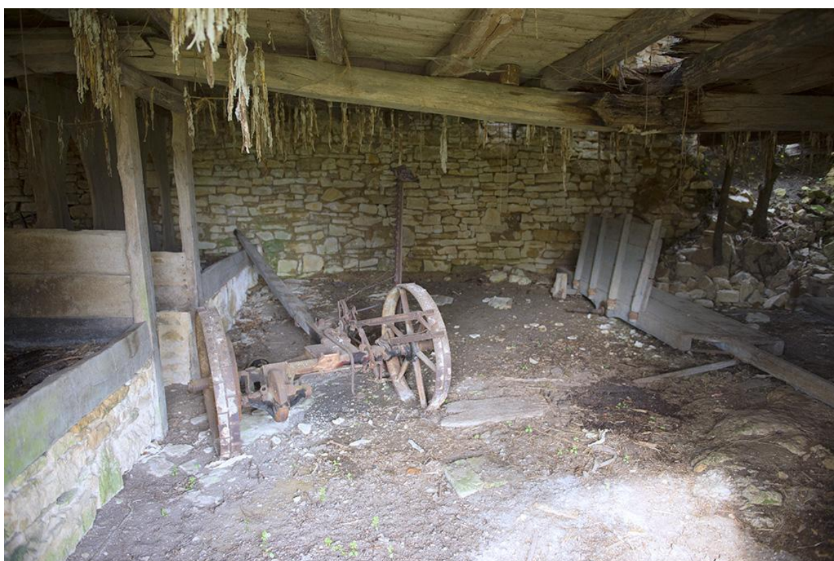
Fig. 30 - Grange N° 2 : la travée centrale, où la poutre, en très mauvais état, menace de rompre.
