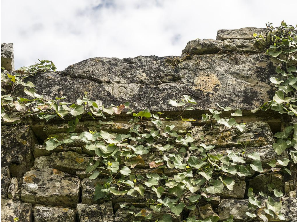
Fig. 40 - Ruine de la maison des Huzol : détail du linteau avec début de millésime.
