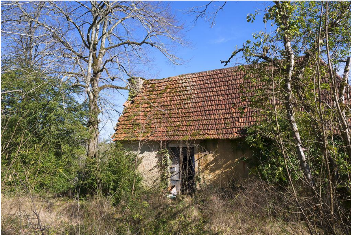
Fig. 10 - La maison : façade Ouest.
