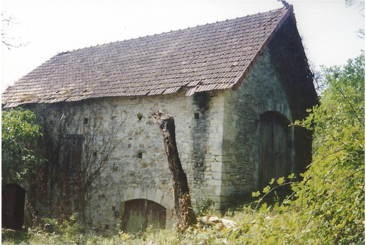
Fig. 55 - Grange N°1 avec la toiture encore présente ainsi que son chaînage d'angle.
