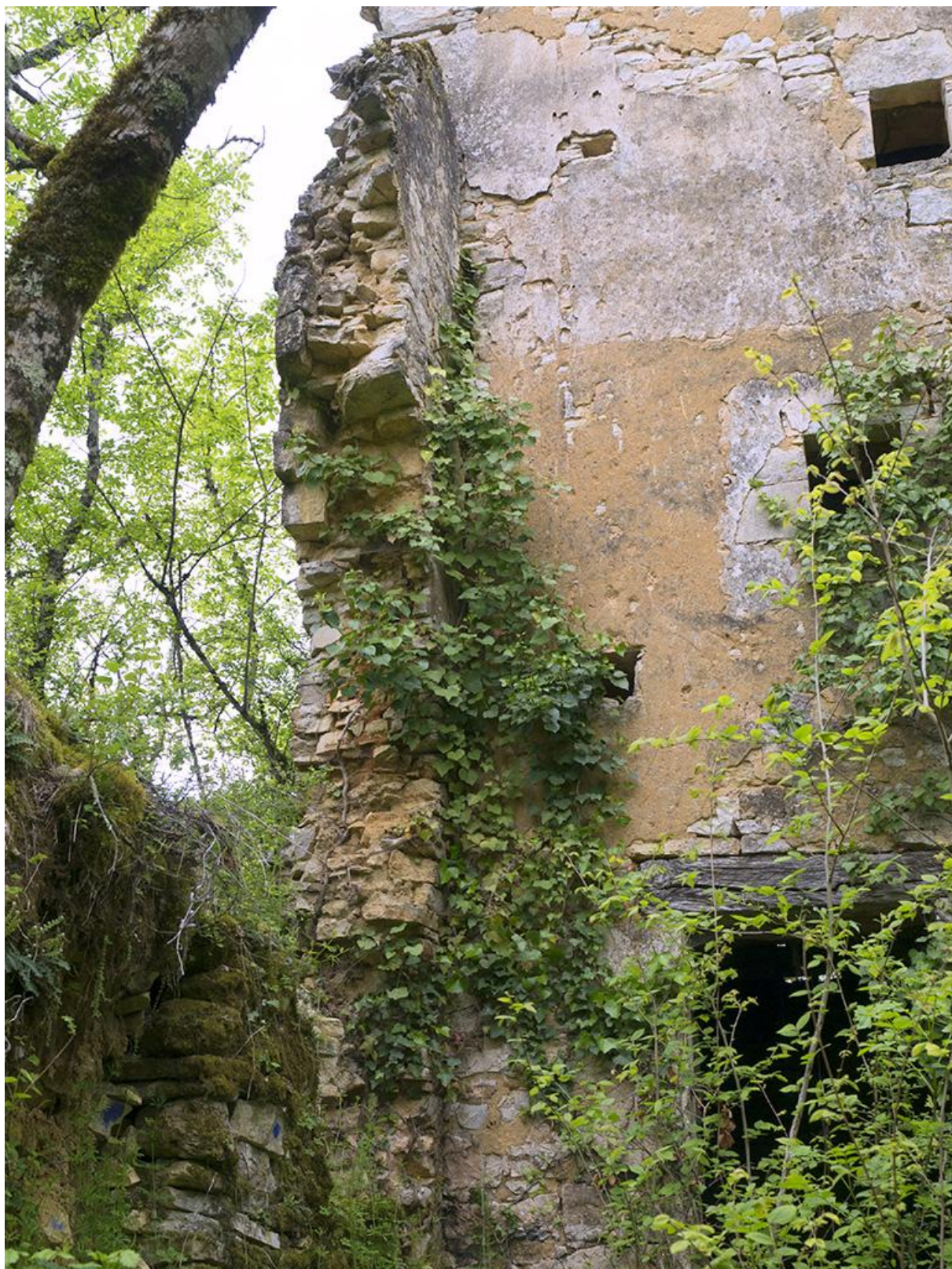
Fig. 36 - Le pigeonnier : restes du mur de la construction attenante.
