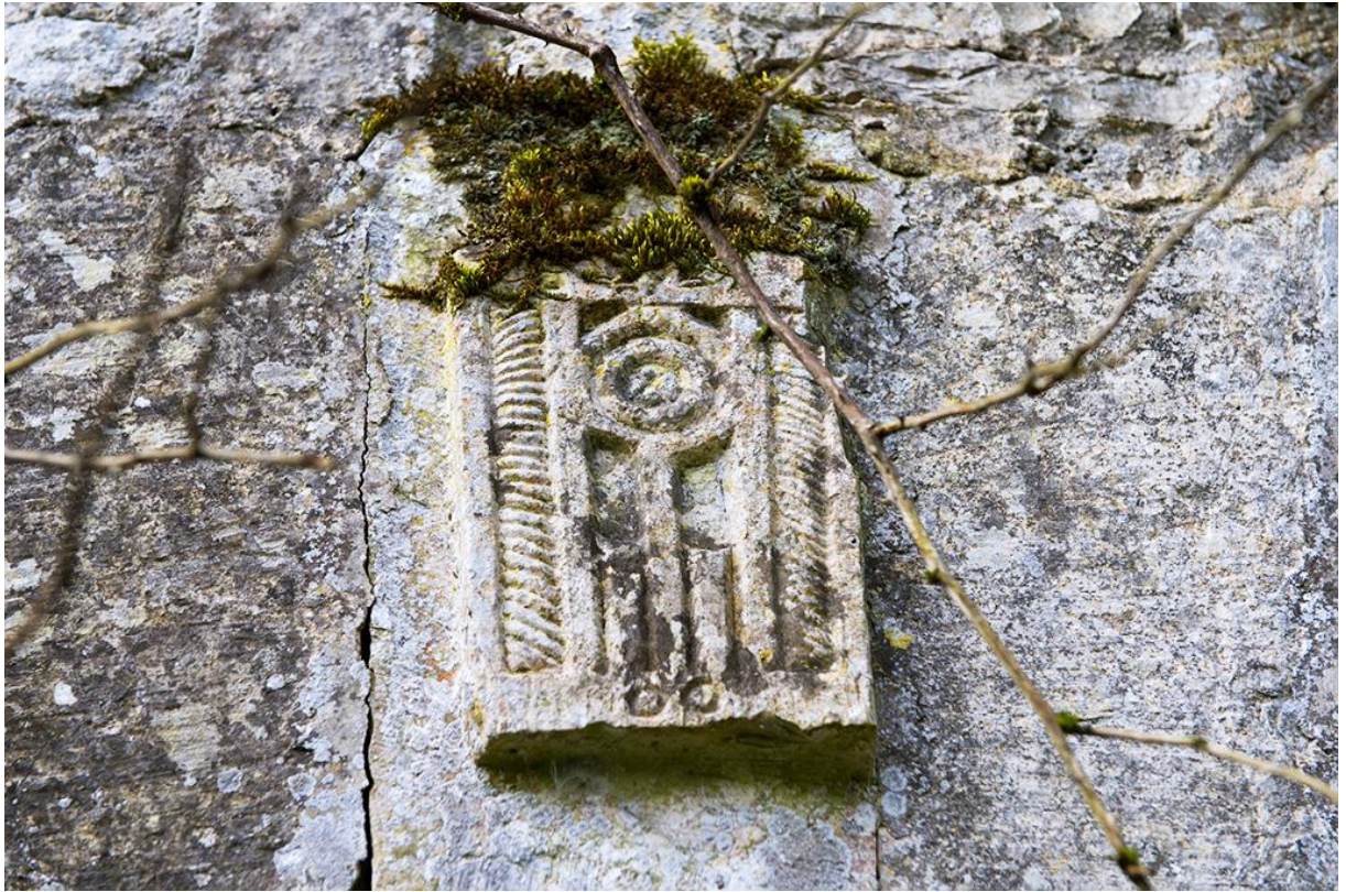
Fig. 20 - Grange N° 1 : clé sculptée de l'arc de la seconde entrée du gouttereau Nord. Le motif semble être une clé de serrure !
