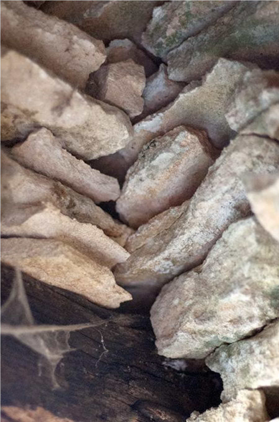
Fig. 23 – Hiatus 3 au-dessus de l'arrière-linteau de la cellule B.
