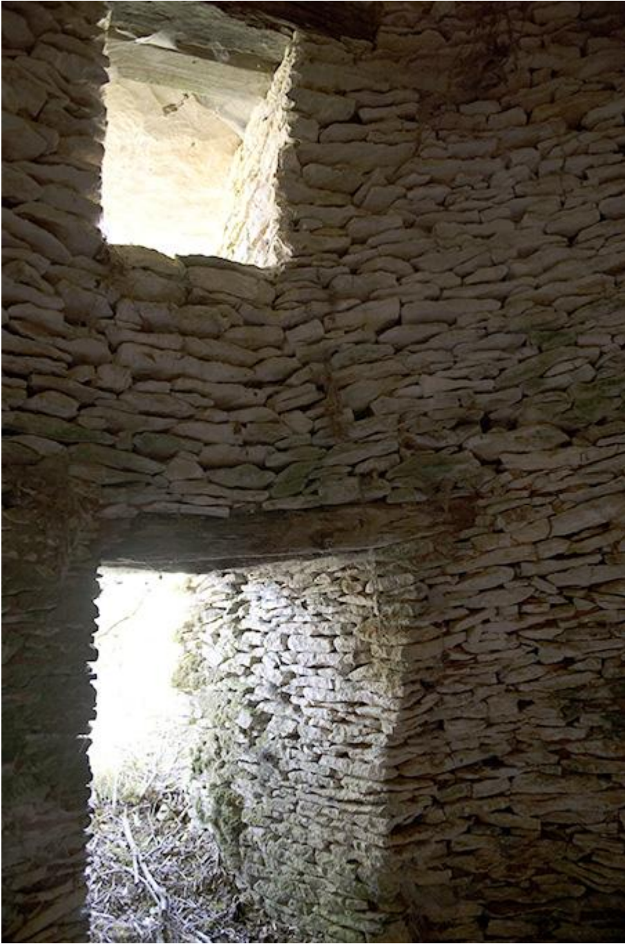
Fig. 32 - L'entrée de la cellule A, le jambage côté droit, en regardant vers l'extérieur.
