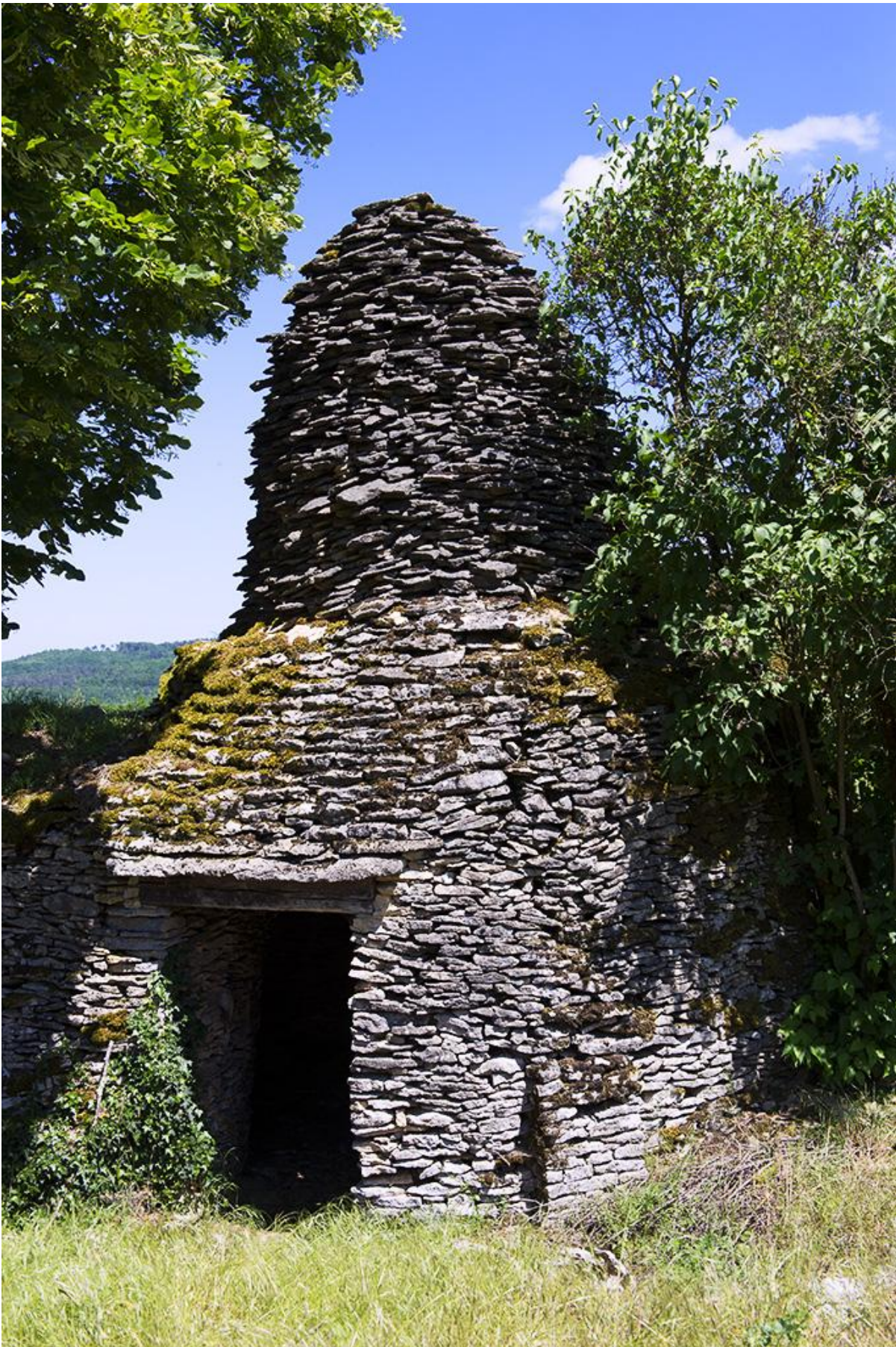
Fig. 16 - Cabane de Valojoux 2015, cellule B. Avec ses branchages touchant l'extrados de la voûte, l'arbre poussant sur la droite est un danger pour la conservation du bâtiment.
