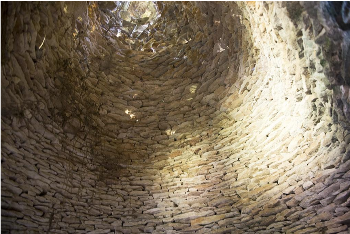
Fig. 27 - Voûte d'encorbellement de la cellule A.
