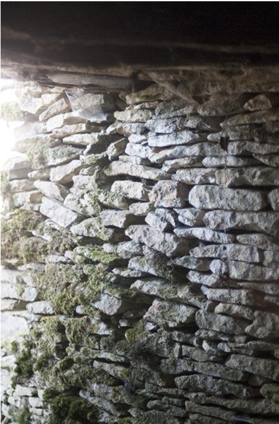
Fig. 33 - Cliché rapproché de la fig. 32. Un écartement entre les pierres est visible à l'aplomb du premier linteau. Il s'agit non pas d'une « lézarde » du jambage mais du début du tas d'épierrement (Fig. 34).
