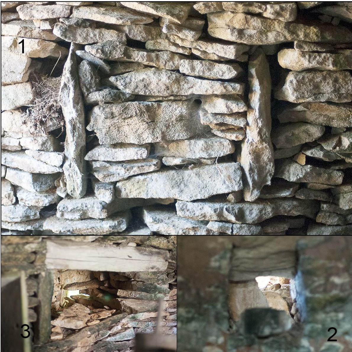
Fig. 21 - Photo N° 1, niche obstruée dans le mur qui accède au couloir ; photo N° 2, ouverture cellule A ; photo N°3, ouverture cellule B.
