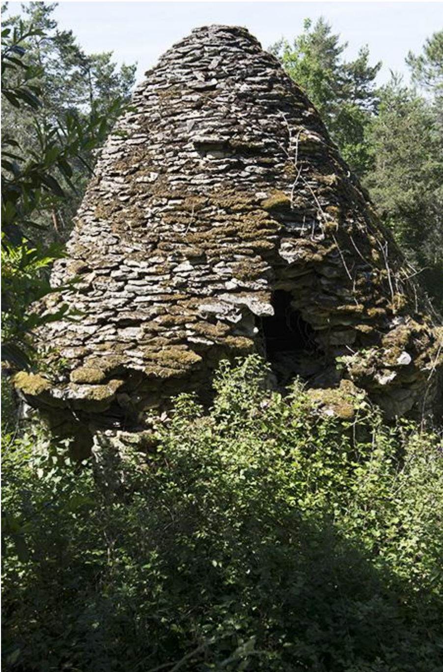
Fig. 37 - Cabane qui existe sur l'ancien cadastre de 1813, située à 250 mètres des autres constructions. Elle donne une idée de la forme initiale de la couverture de lauses des cabanes « jumelles ».
