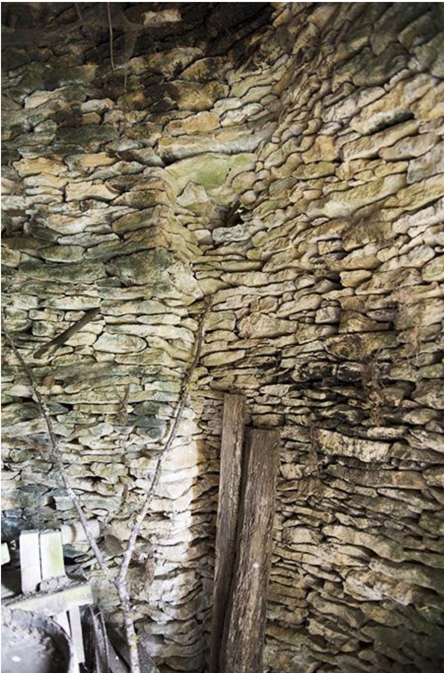
Fig. 18 - Décrochement important visible sur la droite de l'entrée de la cellule B (hiatus 2).
