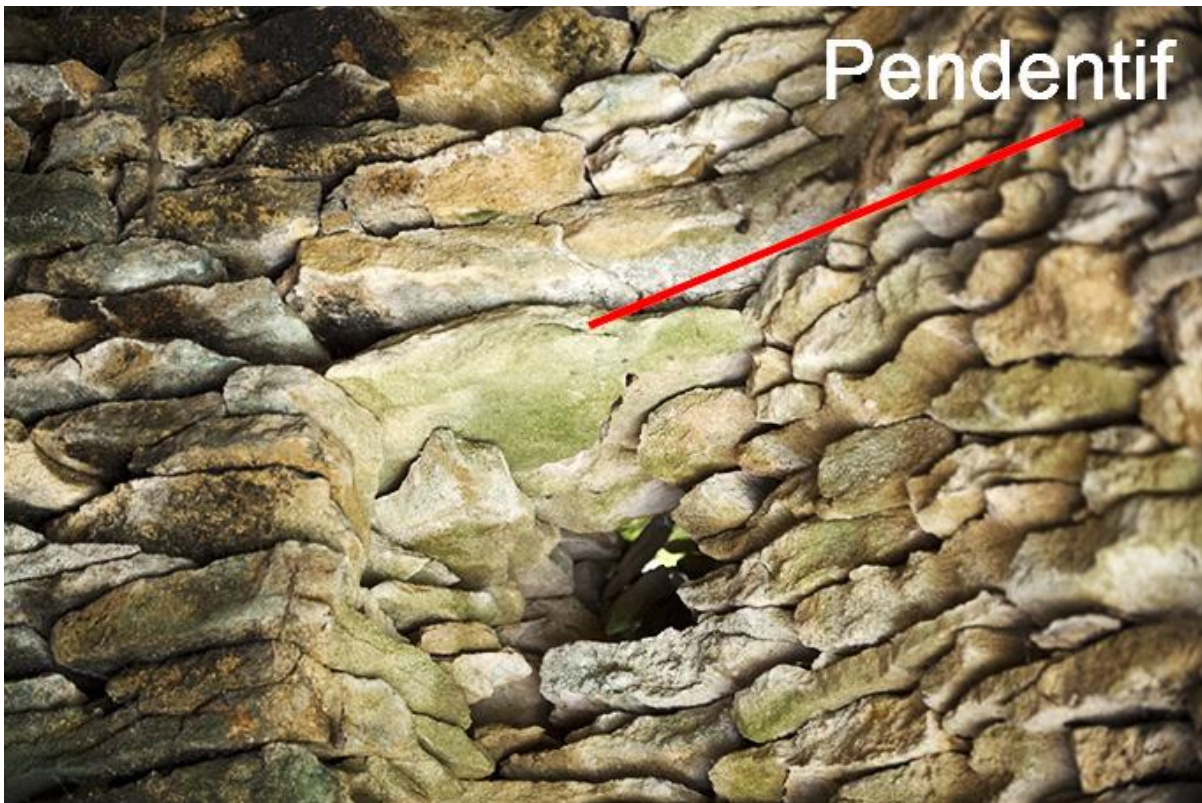
Fig. 20 - Pierre faisant office de pendentif et couvrant le décrochement pour bâtir la voûte ainsi qu'une ouverture vers l'extérieur (cette ouverture à travers la paroi pourrait bien avoir accueilli un conduit pour évacuer la fumée d'un poêle en fonte).
