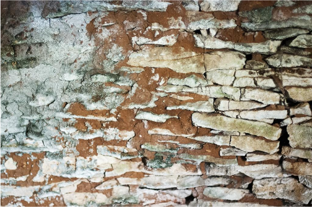
Fig. 25 - Cellule A bâtie à la terre.
