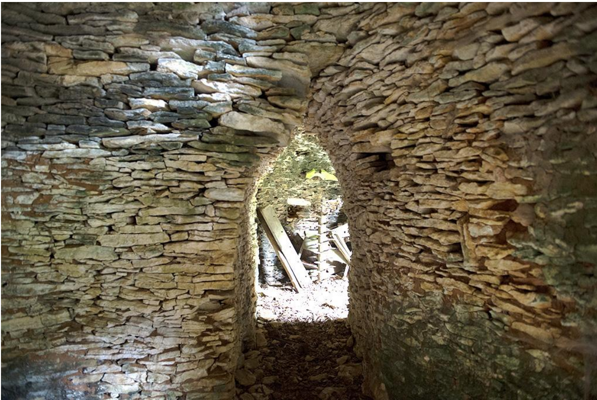
Fig. 24 - Couloir vu à partir de la cellule A vers la cellule B.
