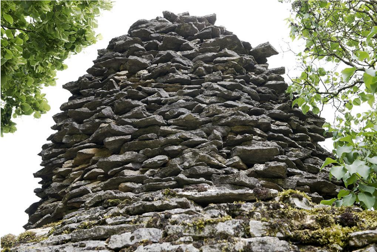
Fig. 17 - Partie hérissonnée formée par l'extrados de la voûte d'encorbellement, cellule B.
