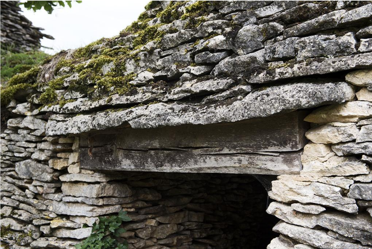
Fig. 13 - Dalle larmière et scellement au mortier des pierres de chaque côté du linteau.
