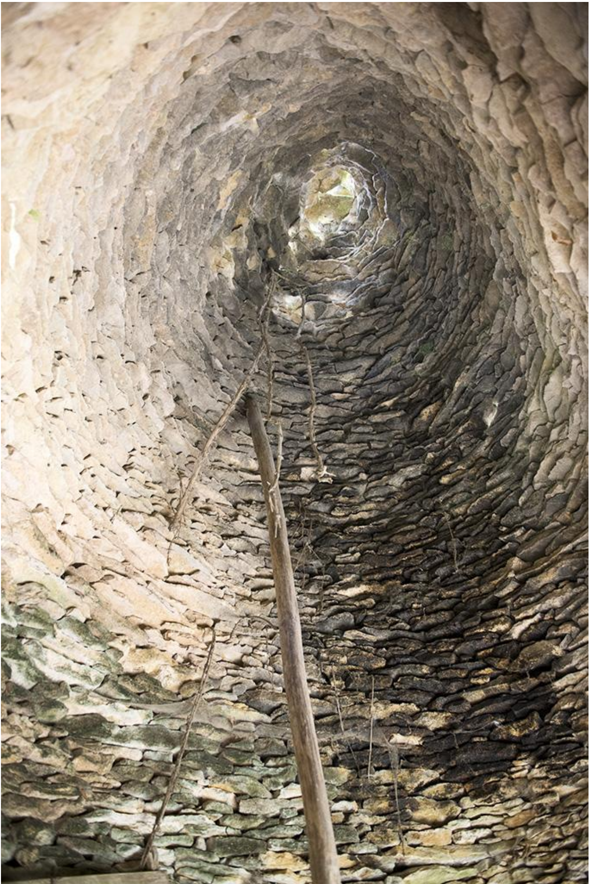
Fig. 26 - Voûte d'encorbellement de la cellule B.
