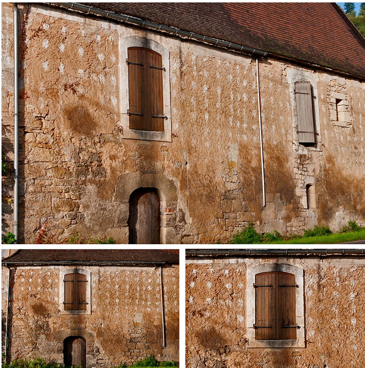
Figure 1 Maison de Mme Trémoulet - Pont de Cause St-Cybranet
