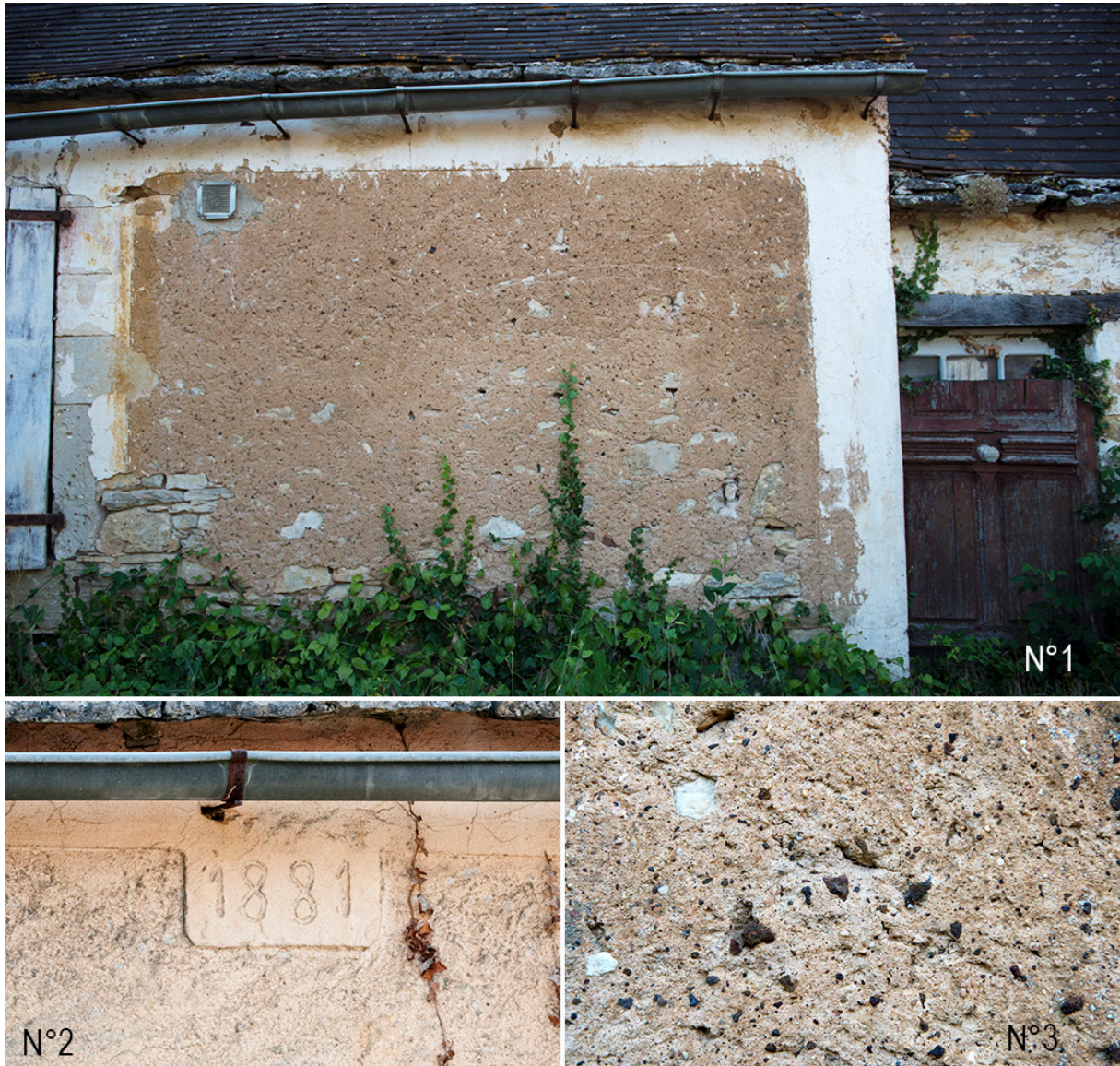
Figure 10 Maison M. Garrouty - Grézelle St-Cybranet - Détail de l'enduit et Millésime
