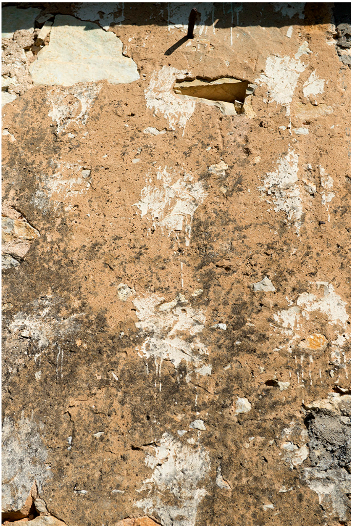
Figure 8 Détail des taches badigeonnées au lait de chaux
