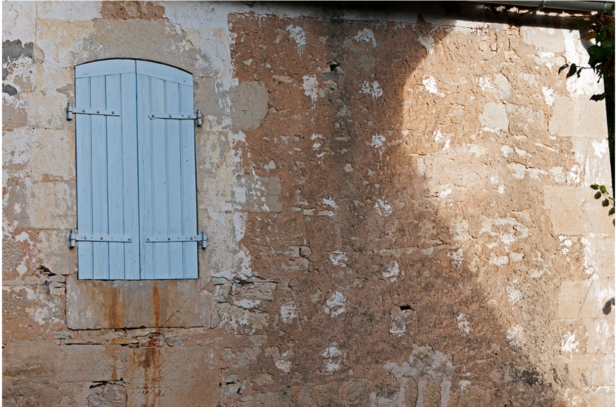
Figure 3 Taches peintes au lait de chaux
