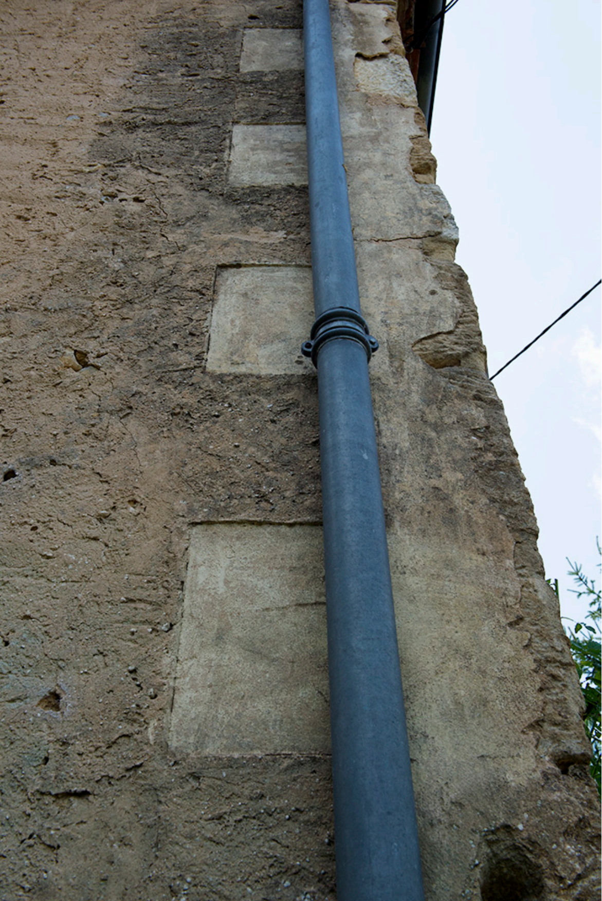
Figure 5 Détail du chaînage
