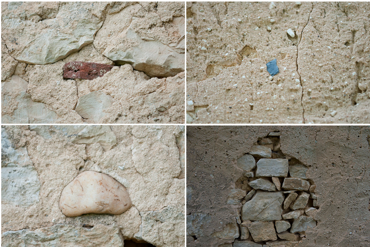
Figure 6 Détail de l'enduit, en bas à droite quelques « soustilles »
